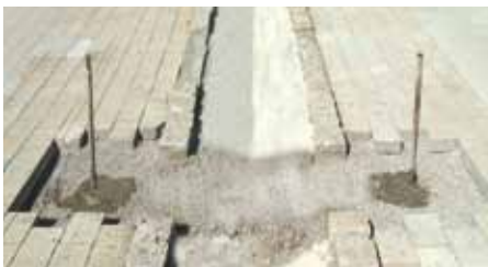
Fertig gesetzte Injektionspfähle
