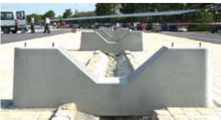
Fertigteil Fundament gesetzt und ausnivelliert
