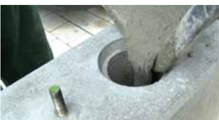
Ausgießen der Fundamente mit Vergussmörtel
